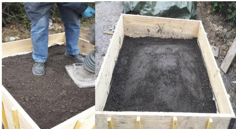
*Figure.III. 1. 18 Mise en place et compactage du mélange des sédiments*
