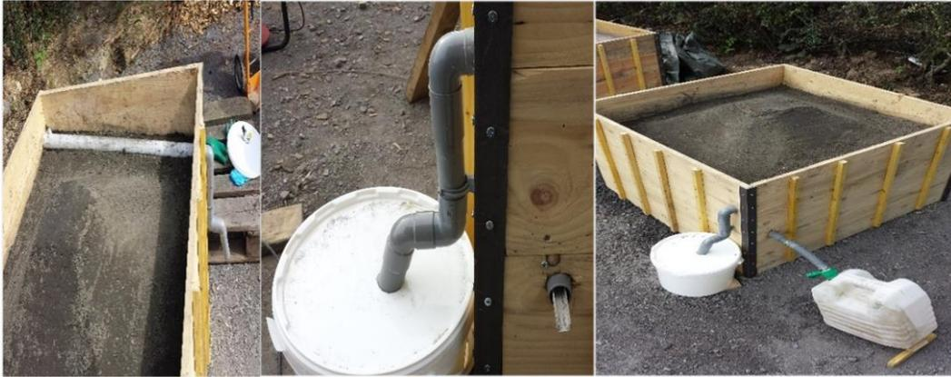
*Figure.III. 1. 19 Installations des conduites des eaux de ruissellement et de percolation*
