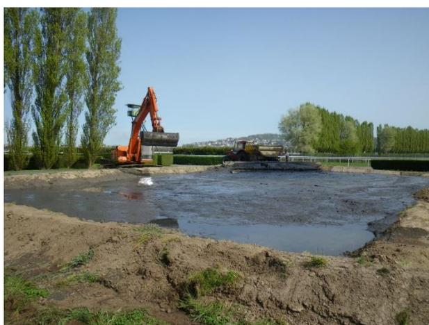
*Figure I.3. Bassin de stockage provisoire et non confiné des sédiments*
