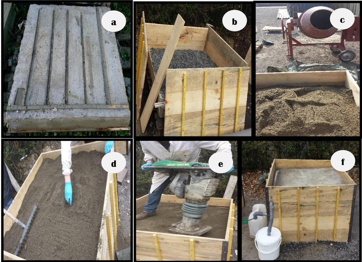
*Figure.III. 2. 16 Étapes de réalisation de la planche expérimentale*
