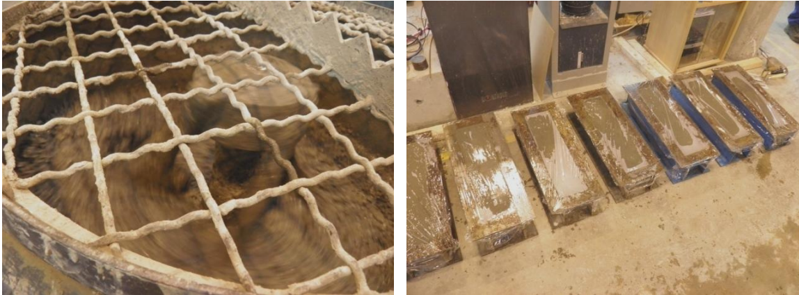
Fig. 2. 1 : Coulage et répartition de béton et protection de coffrages après coulage
