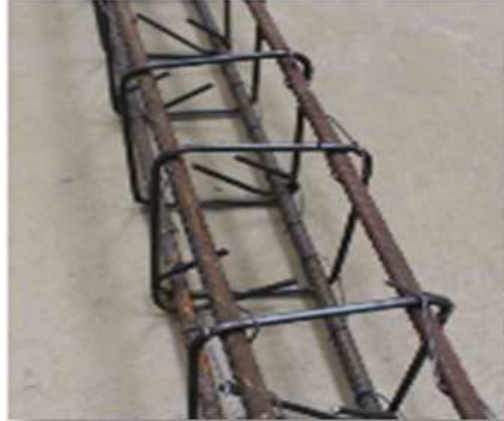
Figure 2.3 : Ferrailage d'un poteau
