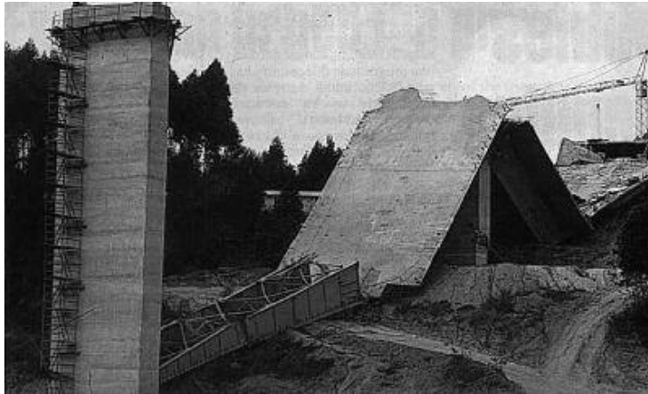
Figure 1 .1: Effondrement du pont d'Injaka (Afrique du sud), en juillet 1998 [2].
