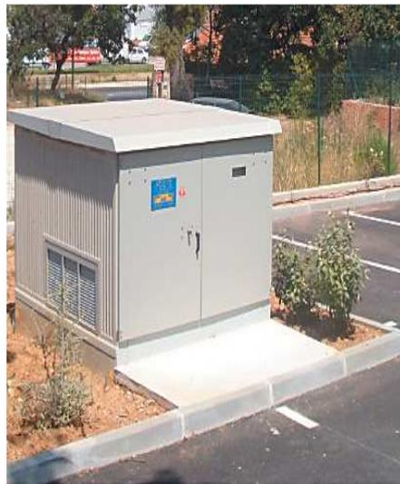
Figure 1.8 : Poste de distribution HTA/BTA type « cabine ».
