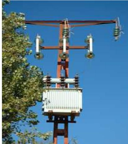
Figure 1.7 : Poste de distribution HTA/BTA type « poteau ».
