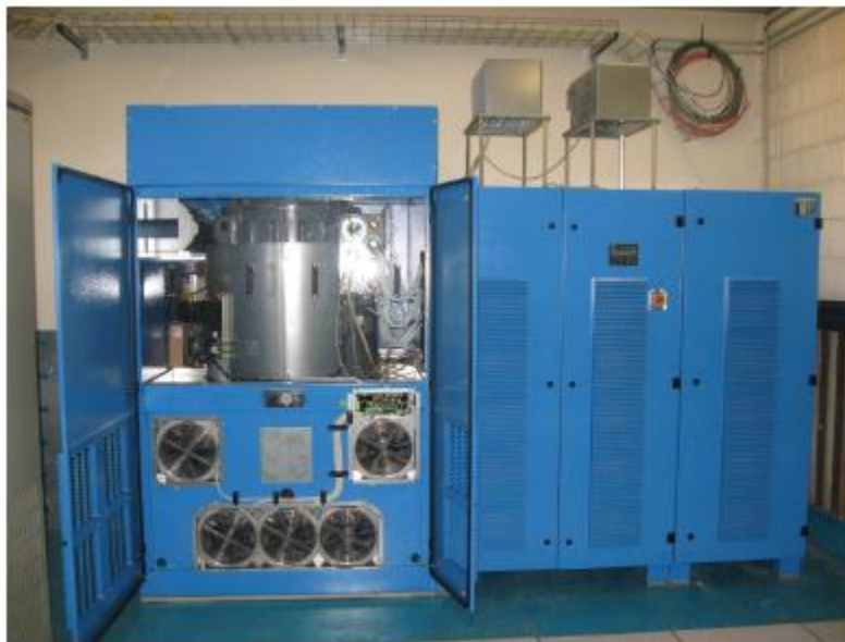
Figure 1.13 Application stationnaire à volant d’inertie du métro de Rennes [BOI-11]
