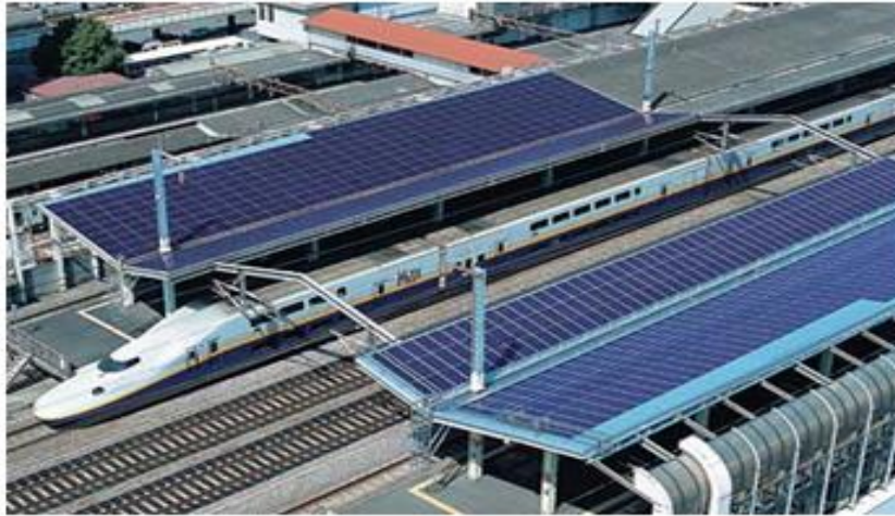
Figure 1.16 Système PV de 200 kW installé à la station de Takasaki [HAY-11]
