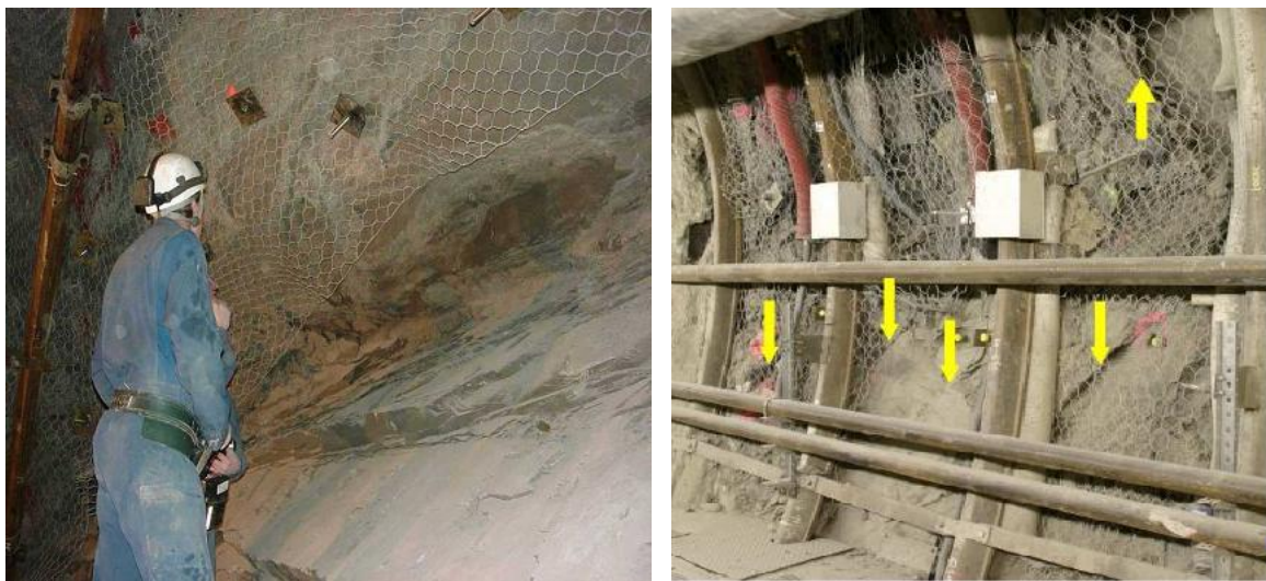
Figure 1.9 Fractures chevrons en front de taille orientée suivant \sigma_H (gauche), en parement orientée suivant \sigma_h
