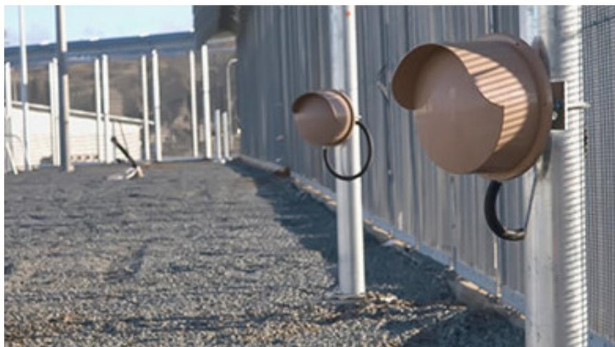
FIGURE 5 – Système de détection d'intrusion par micro-ondes fonctionnant à 24 GHz. [88]
