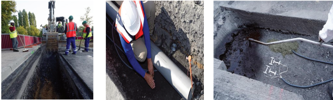
Figure 2.5 : Construction de la tranchée (photos EUROVIA)
