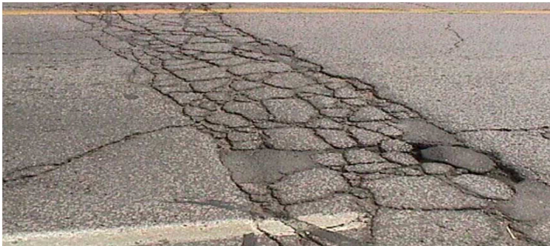
Figure 1.10 : Comportements différentiels entre la zone de tranchée et les zones adjacentes ( Ainley Group 2000 )
