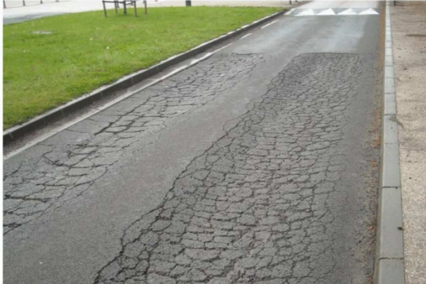
Figure 2.2 : Etat de la chaussée avant l'expérimentation
