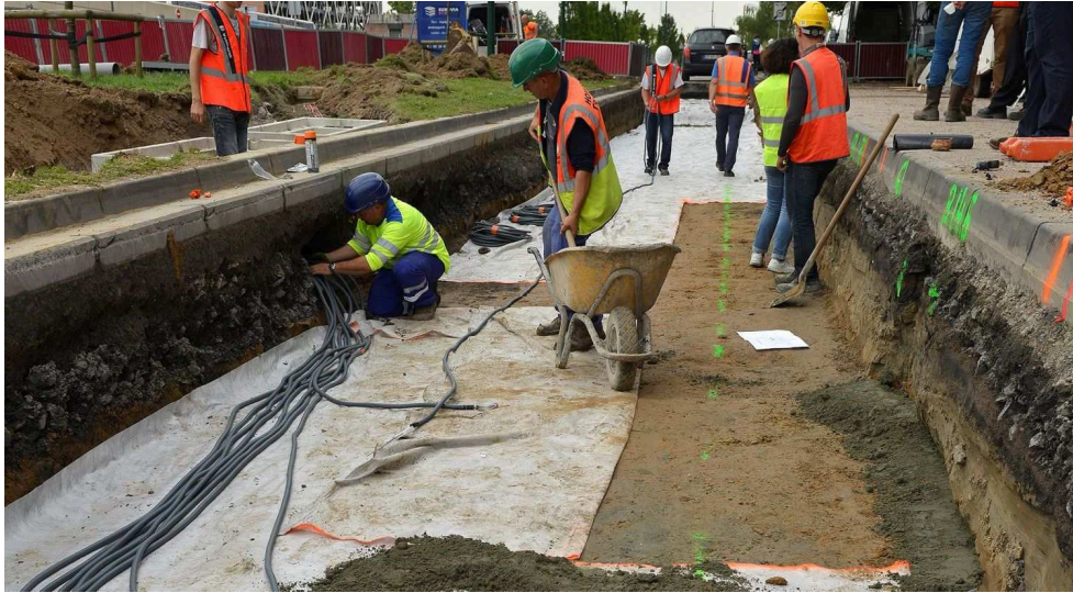
Figure 2.3 : Reconstruction de la Chaussée (photo EUROVIA)
