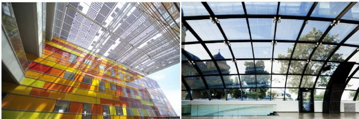
**Figure I-18. Insertion de cellules solaires de seconde génération dans les vitres de bâtiment**
