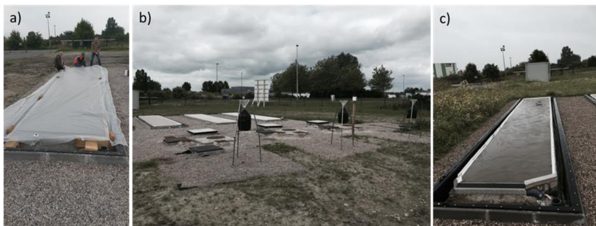
Figure 67. a) Piste lors de la réalisation du pilote ; b) Pilote comprenant les 3 pistes testées, le système de collecte des eaux et les owens ; c) Piste après un évènement pluvieux
