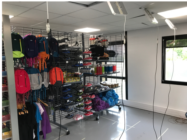
FIGURE 5.17 – Montage des antennes au plafond
