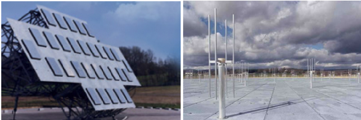
FIGURE 1.15 – Sites constituant le réseau de veille français GRAVES pour l'observation de débris spatiaux dont le diamètre est de l'ordre du mètre à une altitude de 1000 km. Le site d'émission est située à Dijon (à gauche) tandis que le site de réception est situé à Apt sur le Plateau d'Albion (à droite) (© ONERA).
