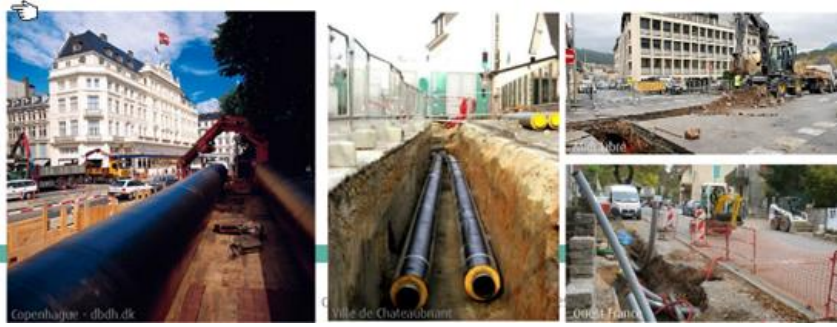
FIGURE 2.1 Conduites enterrées des réseaux de chaleur
