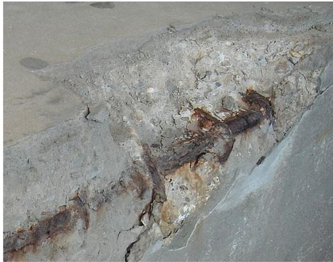
FIGURE 1 – Illustration de l'éclatement du béton armé dû à la réaction de carbonatation (source : MADe – CC-BY-SA, [https://commons.wikimedia.org/wiki/File:Betონrot\\_Hippodroom.JPG](https://commons.wikimedia.org/wiki/File:Betონrot_Hippodroom.JPG)).
