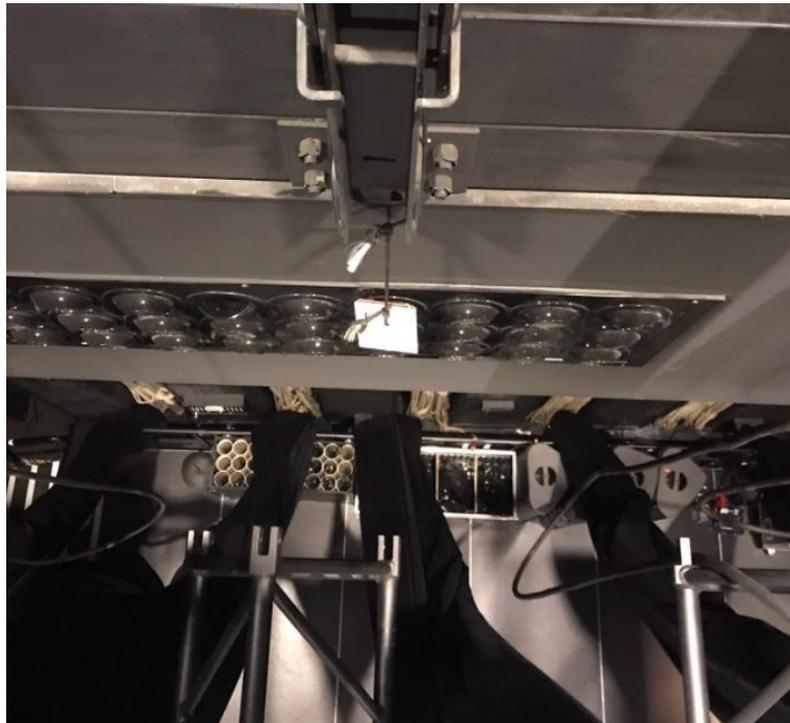
*Figure 5-2: Bouche de soufflage avec un capteur de température installé à son extrémité*
