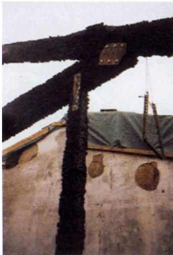
**Figure 17.** Charpente en lamellé-collé après un incendie.
