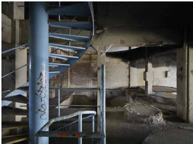
Figure 6 : Ancienne salle à coques de la Brasserie GBM R-1 ©P. BONNIER
