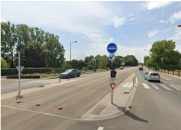
Figure 28 : site propre bus axial bidirectionnel accessible, Le Mans, Tempo 3, Source : Google Maps, mars 2023
