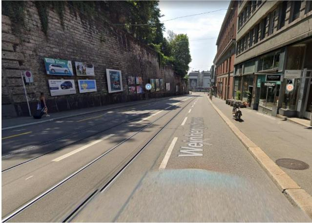
Figure 16 : Site propre tramway non protégé, axial et bidirectionnel, Zurich, Source : Google Maps, 2021
