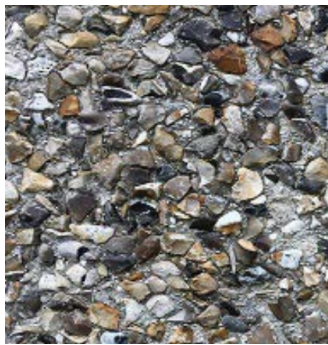
Fig 45 : texture façade existante camus / source personnelle
