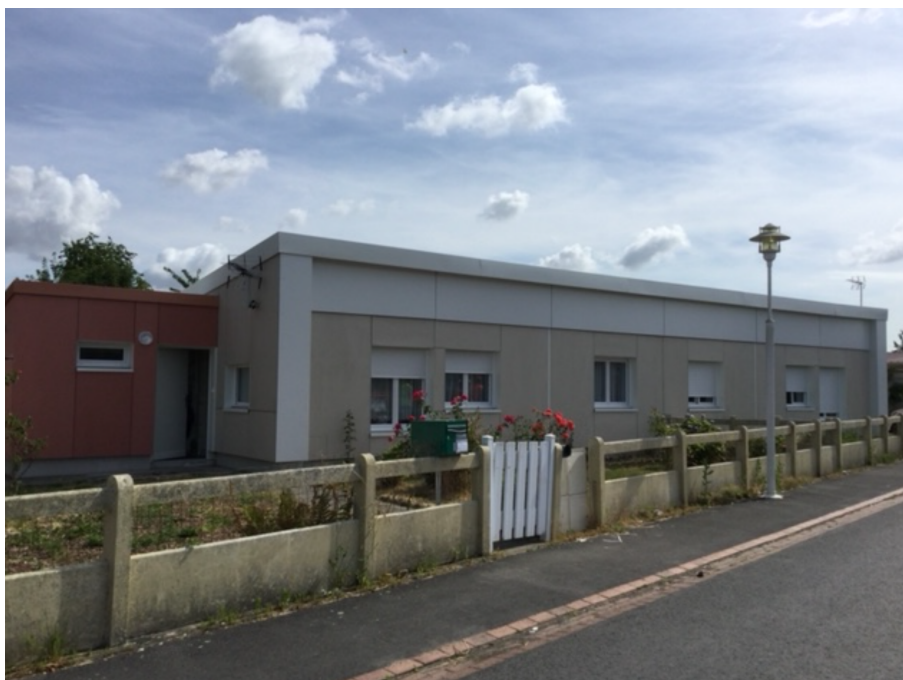
Fig 41 : photographies avant-après travaux camus / source personnelle
