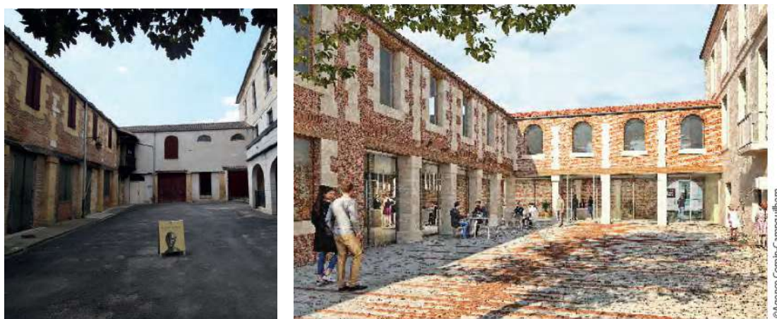
Vue avant les travaux (2021)
