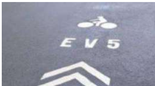
Figure 87 : Signalétique cyclable d'information et directionnelle au sol indiquant la direction à suivre pour rejoindre l'Eurovéloroute 5.
