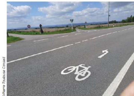
Figure 78 : Signalétique cyclable directionnelle au sol
