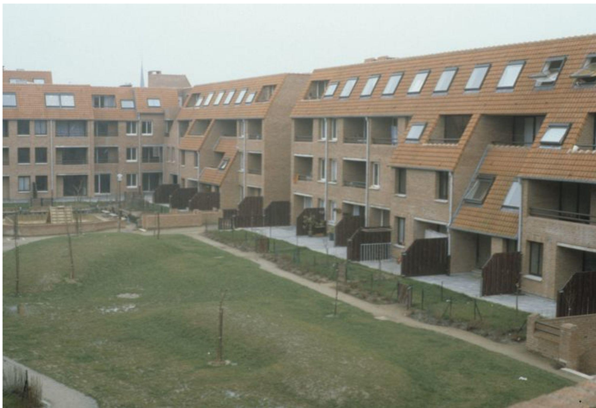
Figure 3 - Figure 3 - Photo - Rénovation de l'Alma Gare - Bibliothèque numérique de Roubaix
