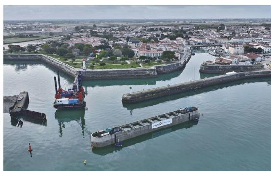
Figure 63 : Mise en place du brise-lames
