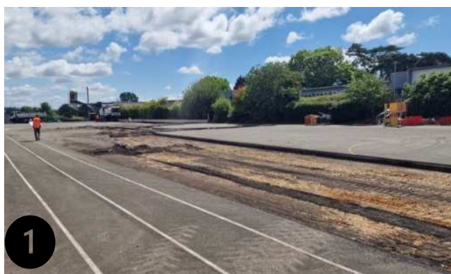
Figure 58 - Photo travaux découpage du revêtement existant conservé, cour Blangy du Bresle ©Mairie Blangy, 2025
