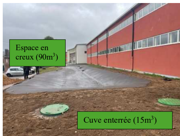
Figure 67 - Photo espace en creux et cuve enterrée avant gauche bâtiment scolaire, cour Blangy sur Bresle ©P.Leroy, 2025
