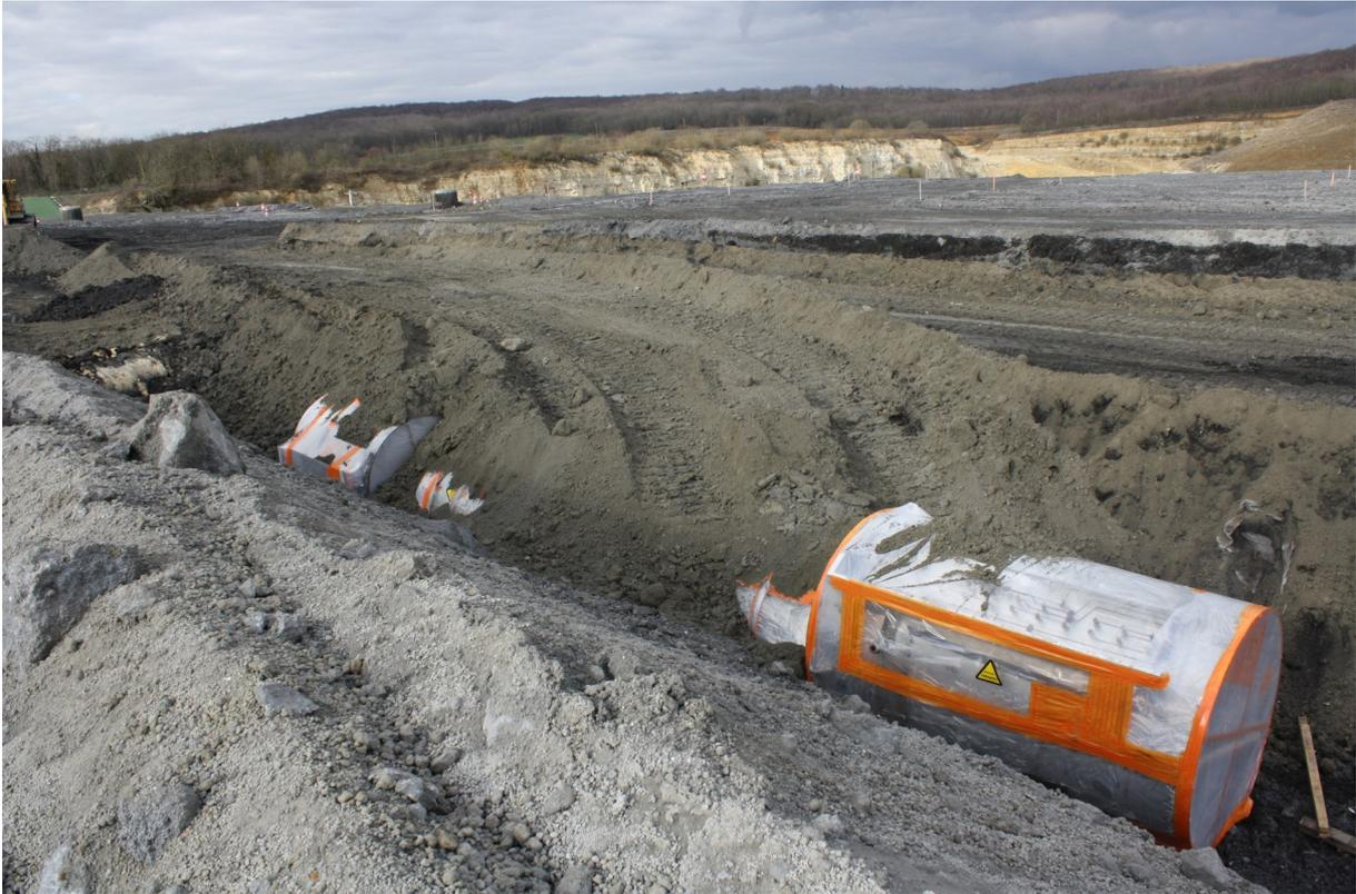
Figure 8 : photo d'enfouissement intégrale d'équipement contenant de l'amiante
