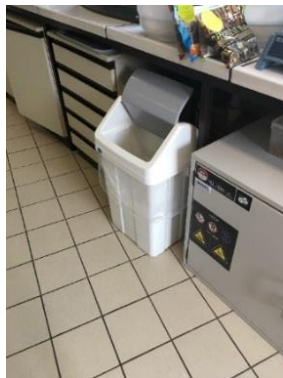
Photo 7 : Poubelles non identifiées et ouvertes à l'air libre
