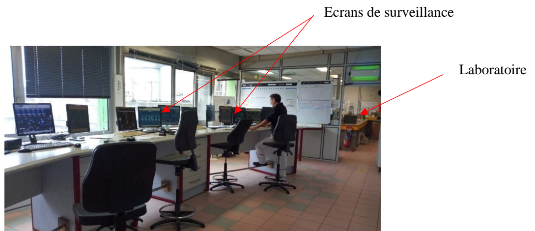
Figure 16. Conduite channel 1 et 2
