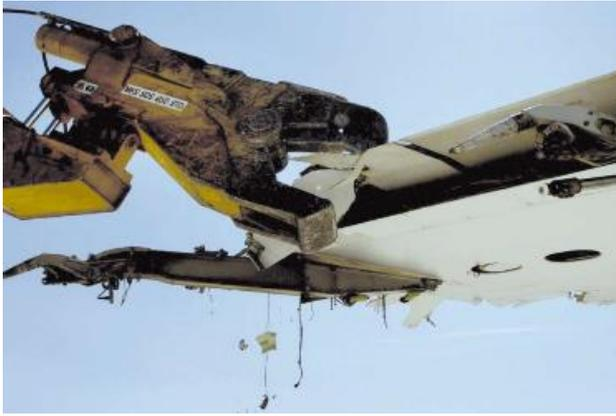
Figure 6 : Exemple de pelle hydrauliques équipé d'une cisaille en bout de flèche (DRIRE DU CENTRE. 2008)
