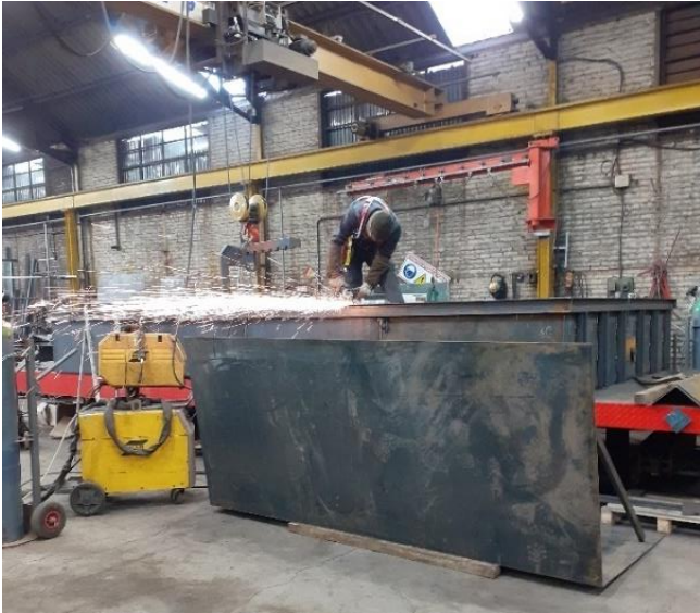
Fabrication bac en acier
