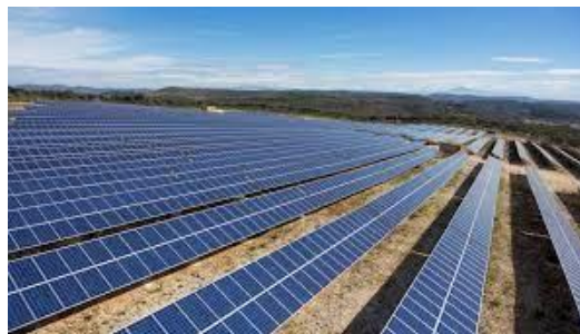
Figure 6 : Parc de panneaux solaires
