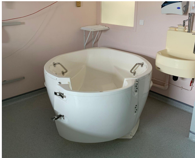
Figure 8 : Photo d'une baignoire d'accouchement dans hôpital privé
