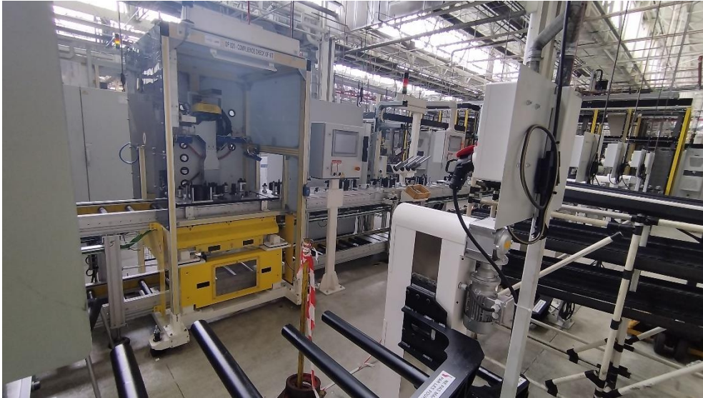
Figure 10 : Photo du poste OP910 - Step 4
