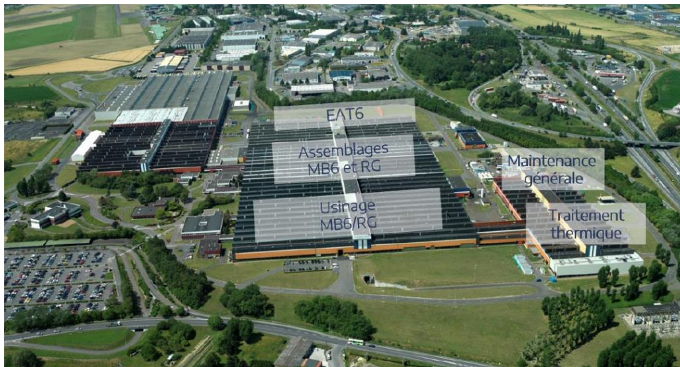
Figure 4 : Photo aérienne des bâtiments de production - Stellantis Valenciennes
