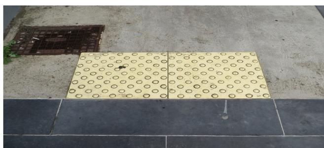
Figure 37: Bande podotactile [photo prise par l'auteur]
