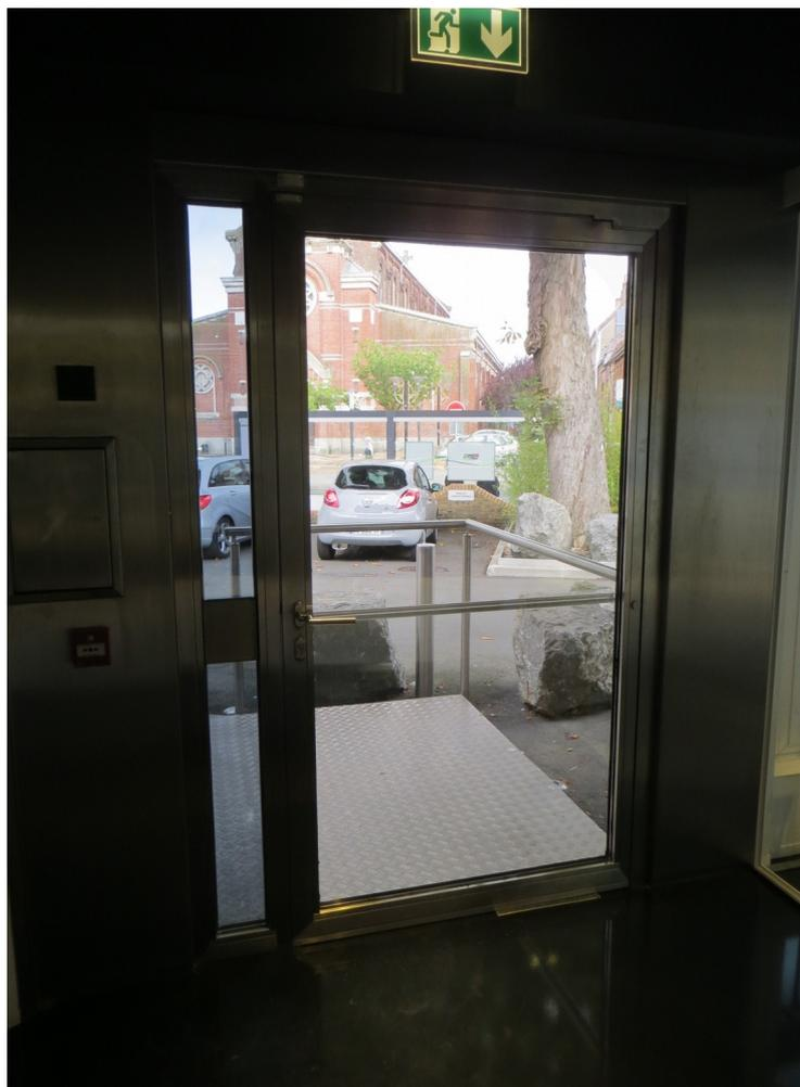
*Figure 28: Porte d'entrée adaptée [photo prise par l'auteur]*
