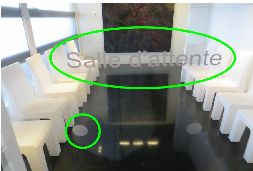
Figure 24: Éléments de repère en entrée et sortie destinés au personnes mal-voyantes [photo prise par l'auteur]
