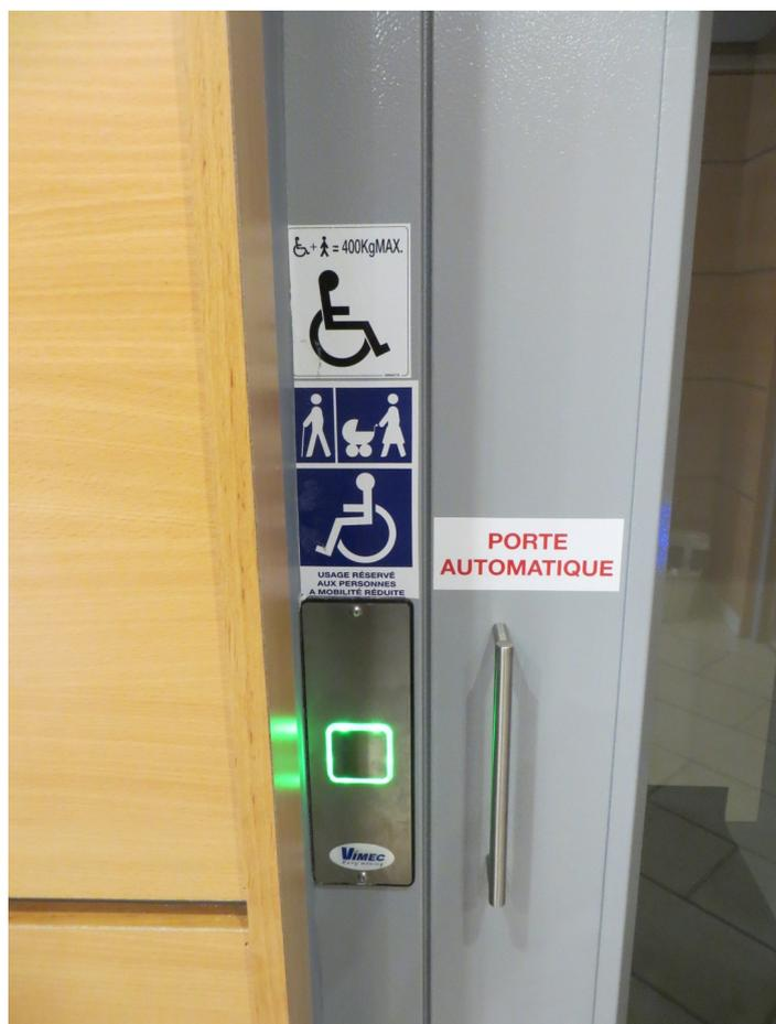
*Figure 39: Pictogramme "usage réservé aux personnes à mobilité réduite" et porte automatique [photo prise par l'auteur]*
