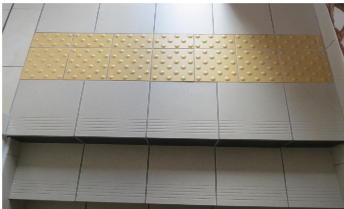
*Figure 41: Bande podotactile située en haut de l'escalier [photo prise par
