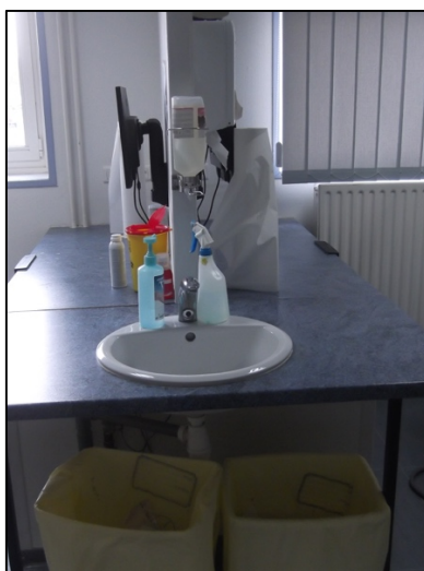
Figure 14 : Exemple de poste de lavage en salle 700
