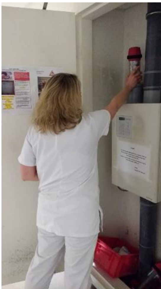
Image 2 : Pneumatique pour l'envoi des bilans directement au laboratoire
