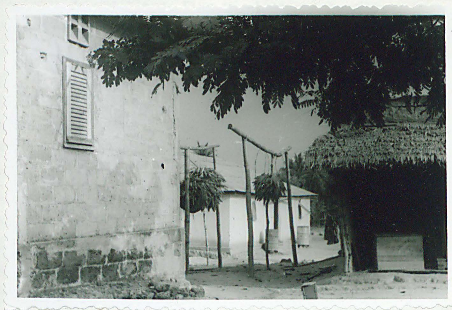
Conservation du maïs : épis secs accrochés à une poutre.
