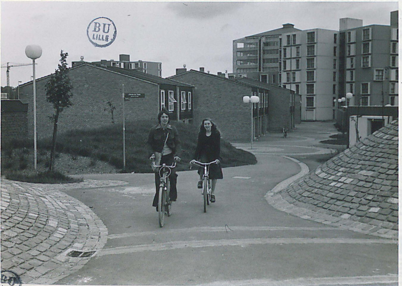
Photos N° 57 et 58 : Exemples de cheminements à Villeneuve d'Ascq. (col. privée)
