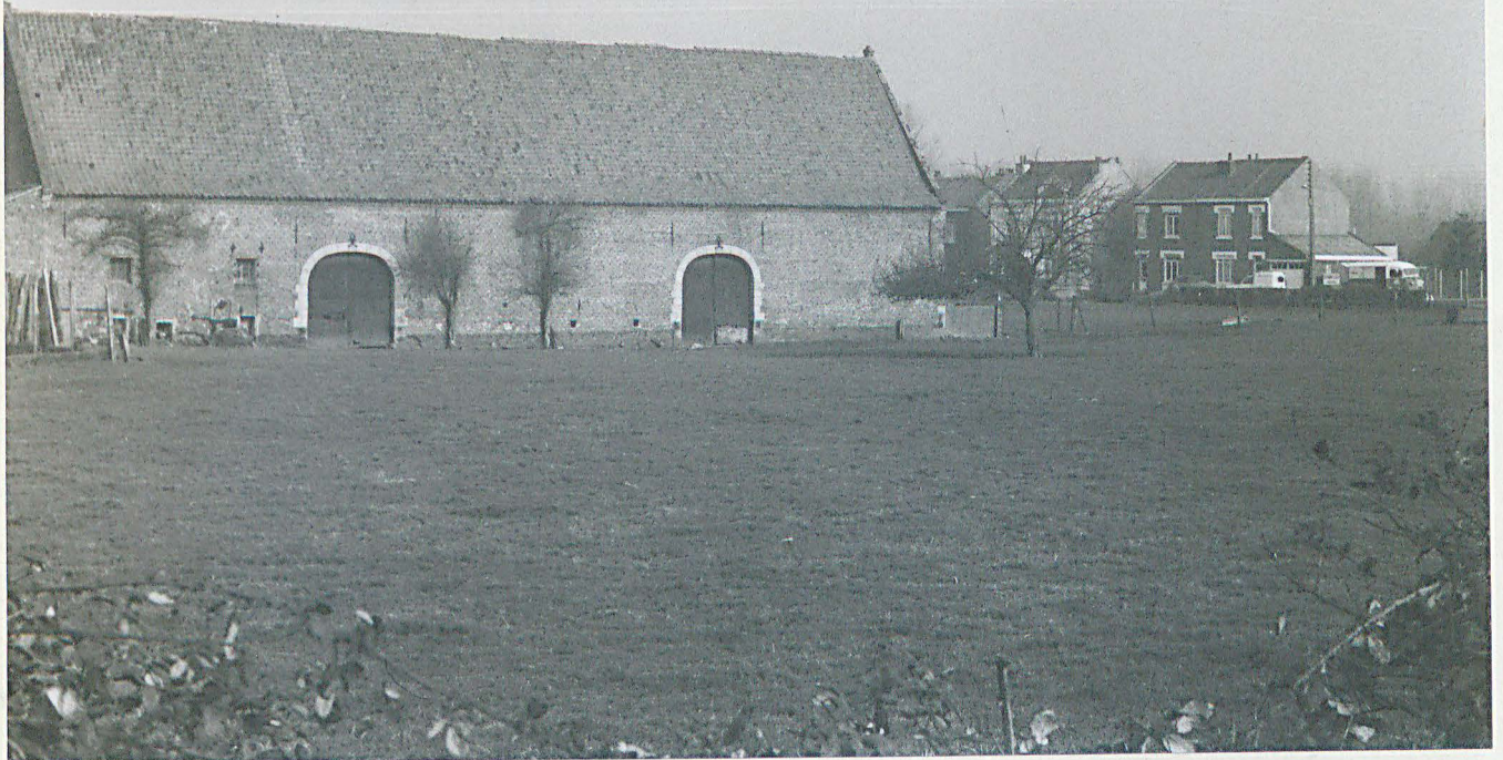
Photo N° 12 : Un bâtiment de ferme à Sainghin-en-Mélantois. (col privée)
