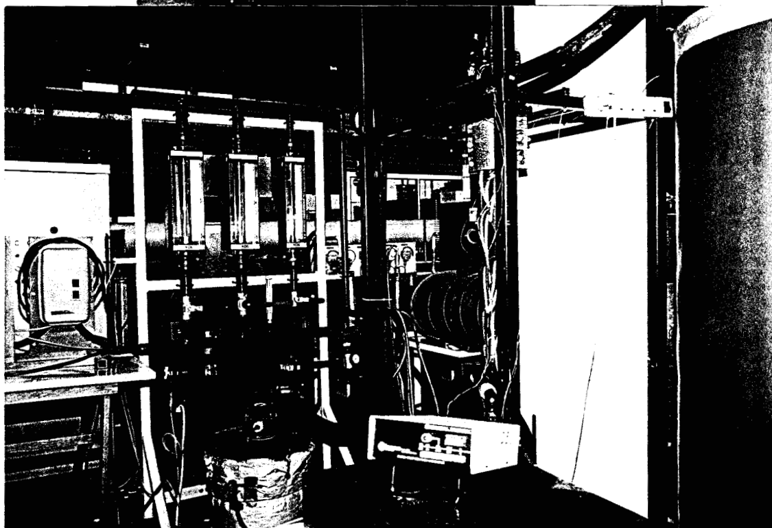
Fig V.4 - Photos de l'installation
