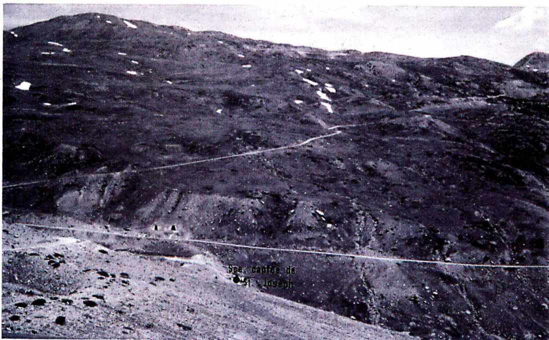
PHOTO. 23 - Vue partielle du complexe de coulées du Granon. Le long du tronçon inférieur de la route stratégique du Granon, on distingue aisément l'épaulement du mouvement de terrain. Celui-ci est localement dégradé par de petits ravins et des coulées boueuses superficielles. En arrière, se développe une topographie très irrégulière, où alternent niches d'arrachement secondaires et bossellements d'ampleur pluridécamétrique. A gauche de la source captée de St-Joseph, on aperçoit l'extrémité aval du vallum morainique le plus récent déterminé dans ce haut vallon du torrent de la Salle (G1). Dans le coin inférieur gauche du cliché (sous le virage du chemin carrossable), se dessine le bourrelet frontal d'un petit glacier rocheux, dont la racine est située au pied du flanc méridional de la Montagne du Sachet.
