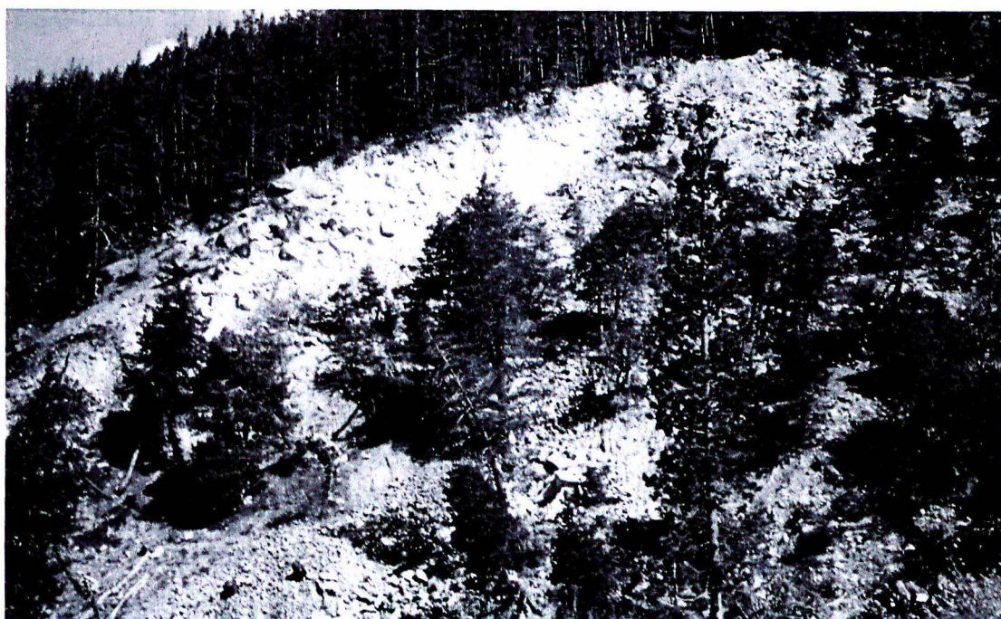
PHOTO. 28 - Cicatrice d'arrachement en rive droite du Grand Verdarel, au niveau de sa confluence avec le Malatra. Le volume de matériaux déstabilisés peut être estimé entre 300.000 et 450.000 m 3 . Il s'agit là d'une menace importante, car le torrent de Verdarel s'écoule à la base de cette énorme masse en équilibre précaire. L'abrupt de tête, lui-même, est très instable : hormis les fissures de régression que l'on peut observer sur le terrain, on devine sur ce cliché qu'il engendre de nombreuses chutes de blocs. Ceux-ci se détachent isolément (à gauche de la photo) ou par éboulement de la matrice sableuse (extrémité droite de la photo)
