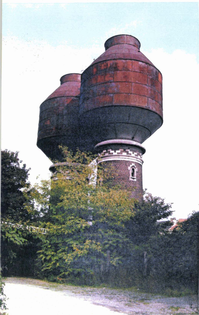
Illustration 10 : Les réservoirs à eau de la gare de Stuivenberg
