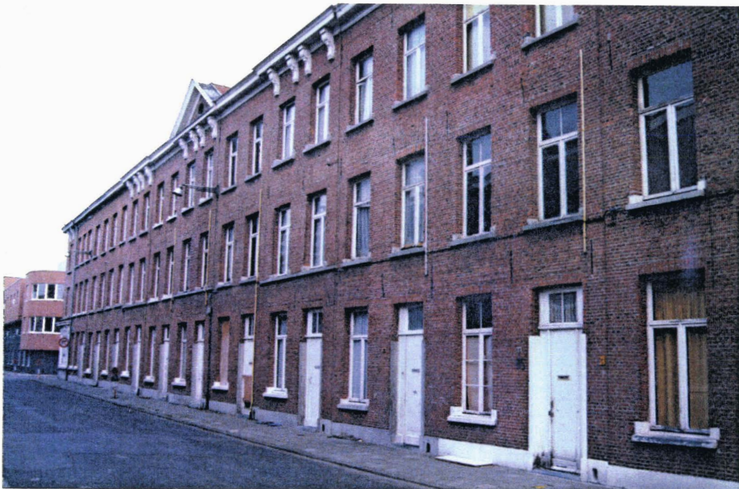
Illustration 13 et 14 : Deux ensembles de logements construits à l'initiative du Bureau de Bienfaisance
