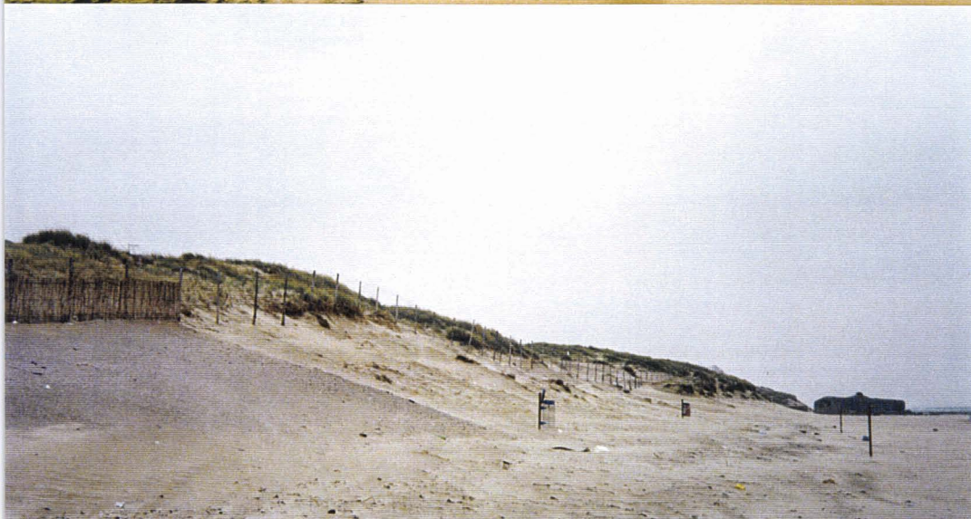
PHOTO N°52 : 1996 , reprofilage du cordon dunaire par apport artificiel de sable sur le haut de plage et le versant littoral, plantation d'oyats, pose de ganivelles, choix de l'emplacement des ouvrages de protection du trait de côte.
