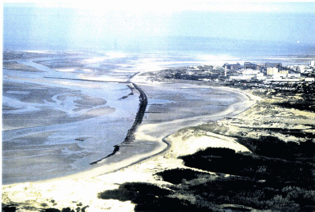
Fig.77a: Le musoir de l'estuaire de l'Authie, près de la Pointe du Haut-Banc.(photo. aérienne, P.Picouet, 29 / 04 / 1994) Fig.77b: Croquis: les ouvrages de protection du musoir.
