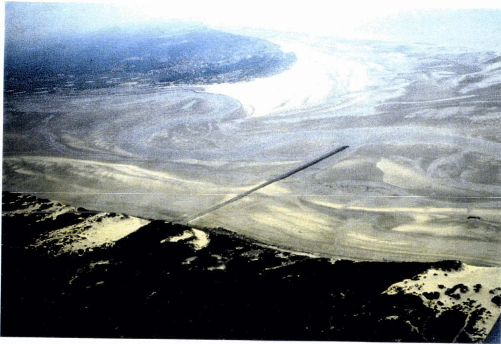
Fig. 109b: Croquis: le grand épis qui bloque le transit des bancs de sable en rive droite.
