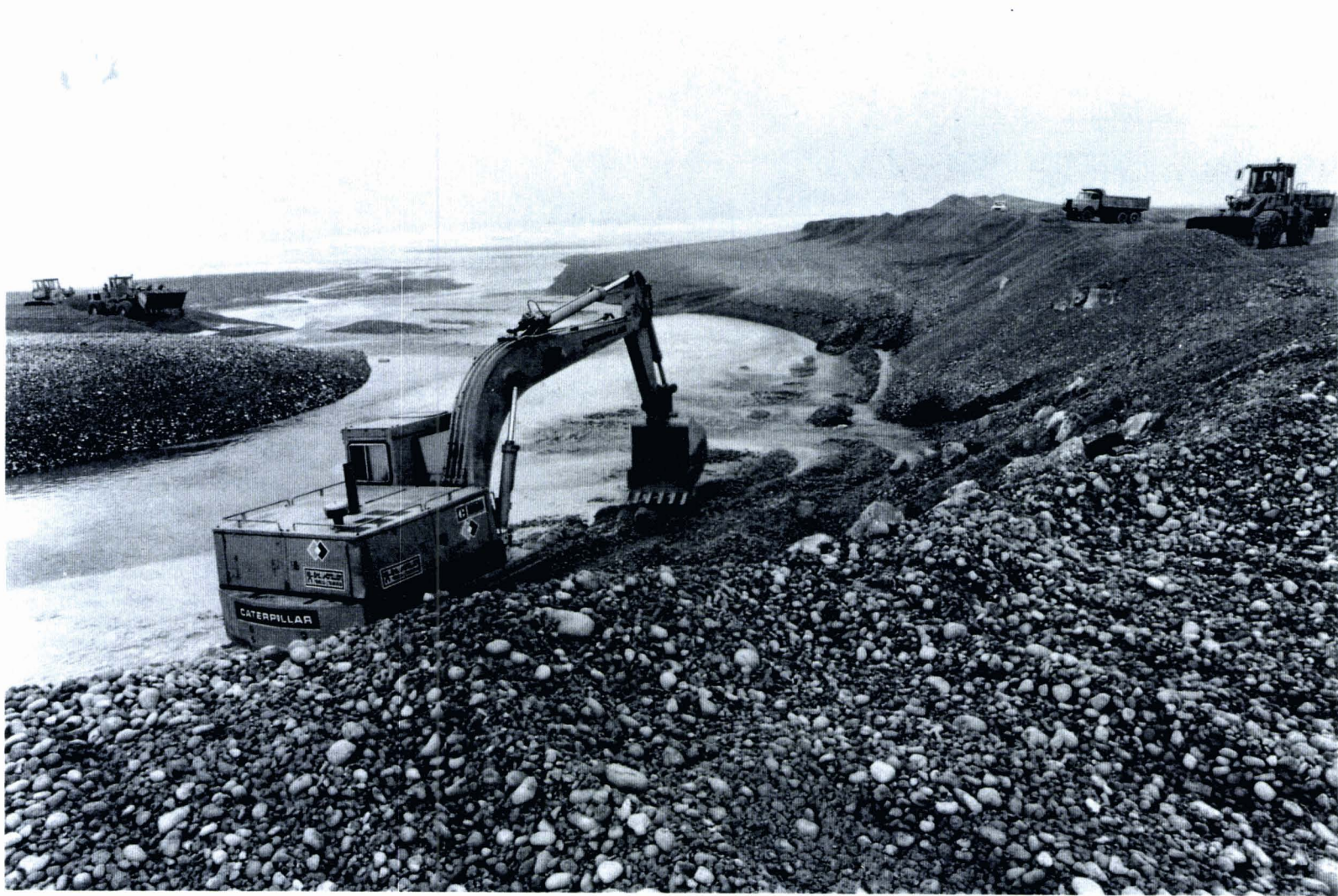
Fig.101: La grande brèche dans le cordon de galets, à marée basse. Des engins entrent en action pour la colmater.(photo, Le Courrier Picard)
