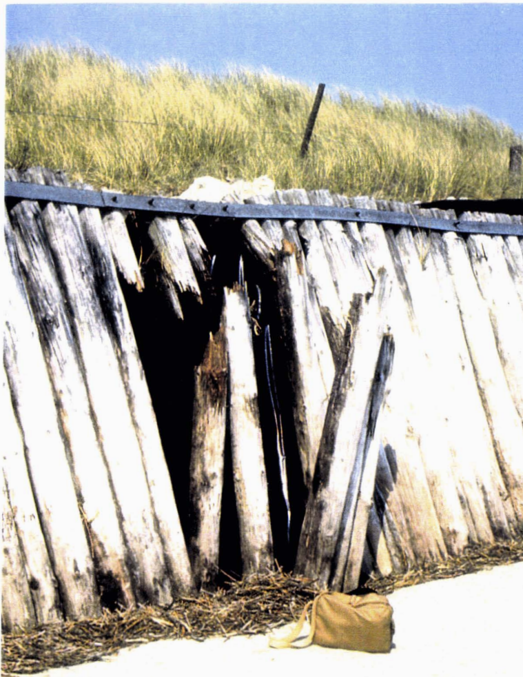
Fig.63: La digue du Parc, destruction partielle du barrage de rondins.(photo., P.Picouet, 2 / 05 / 1995)
