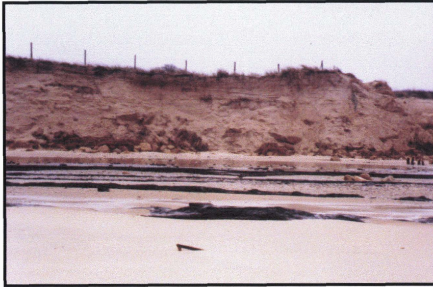
Photo n°48: Vue du front de mer dans le secteur situé en arrière des ouvrages de guerre. L'érosion de l'estran accompagne celle des dunes. On remarque la tourbe sur l'estran et la verticalité de la falaise sableuse. Cliché pris vers le sud-est en février 1998.
