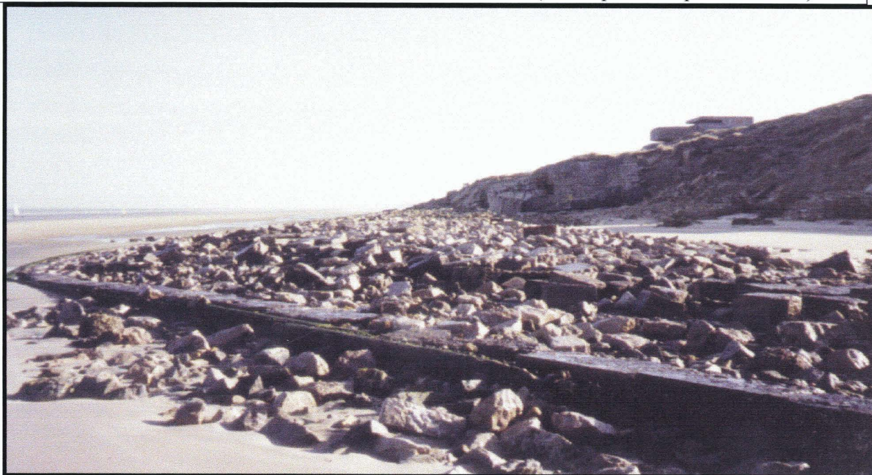
Photo n°30: Vue du front de mer de la batterie de Zuydcoote: les débris forment une protection artificielle en provoquant le déferlement prématuré des vagues, mais accroissent l'érosion de l'estran en perturbant le régime de déferlement (affouillement). Cliché vers l'est en Janvier 1995
