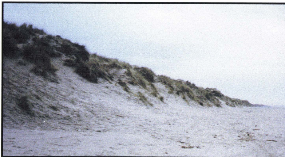
Photo n°39: profil du cordon bordier dans la dune Marchand; cliché pris vers le sud-ouest en avril 1996. Les falaises sableuses se développent sur un cordon reformé depuis moins de 30 ans. Les pentes sont moins importantes que dans la dune Dewulf
