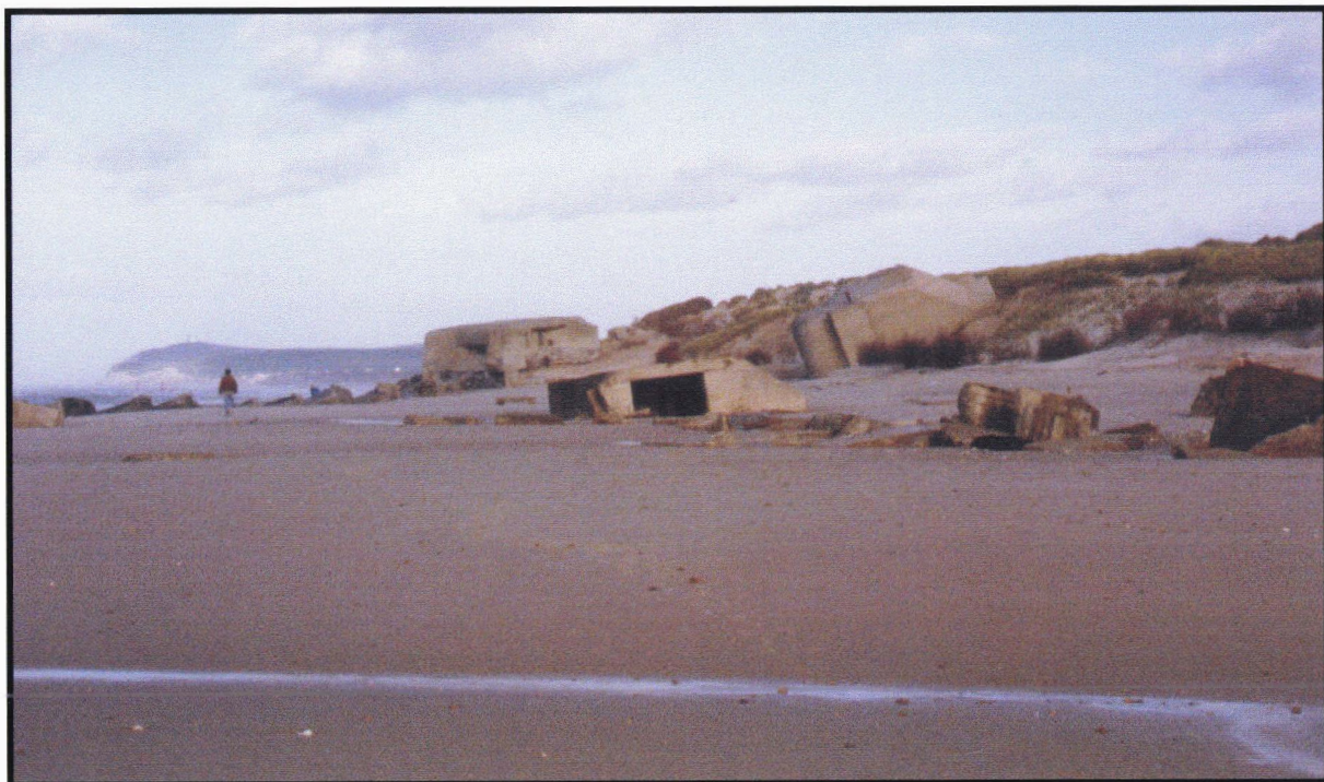
Photo n°46: Vue, des blockhaus situés juste à l'ouest de la digue de Wissant prise en février 1989 vers le nord-est. On remarque le profil équilibré de la dune et la position des blockhaus contre le pied de dune.
