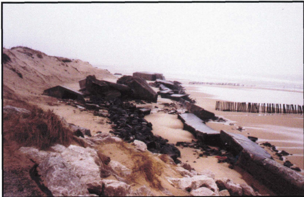
Photo n°49: Vue sur le mur anti-char et la batterie de blockhaus, situés juste à l'ouest de la digue de Wissant. Cliché pris vers l'ouest, Février 1998.
