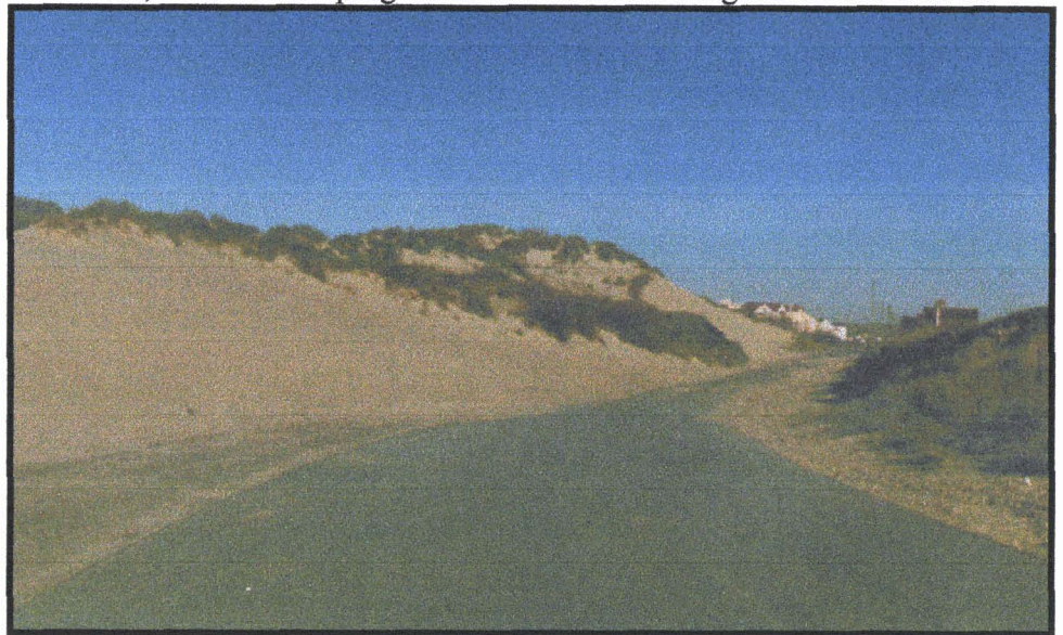
Photo n° 60: Envahissement de la route reliant le camping de la mer à Stella-Plage par des pourrières transgressives. Cliché pris vers le nord en août 1997.
