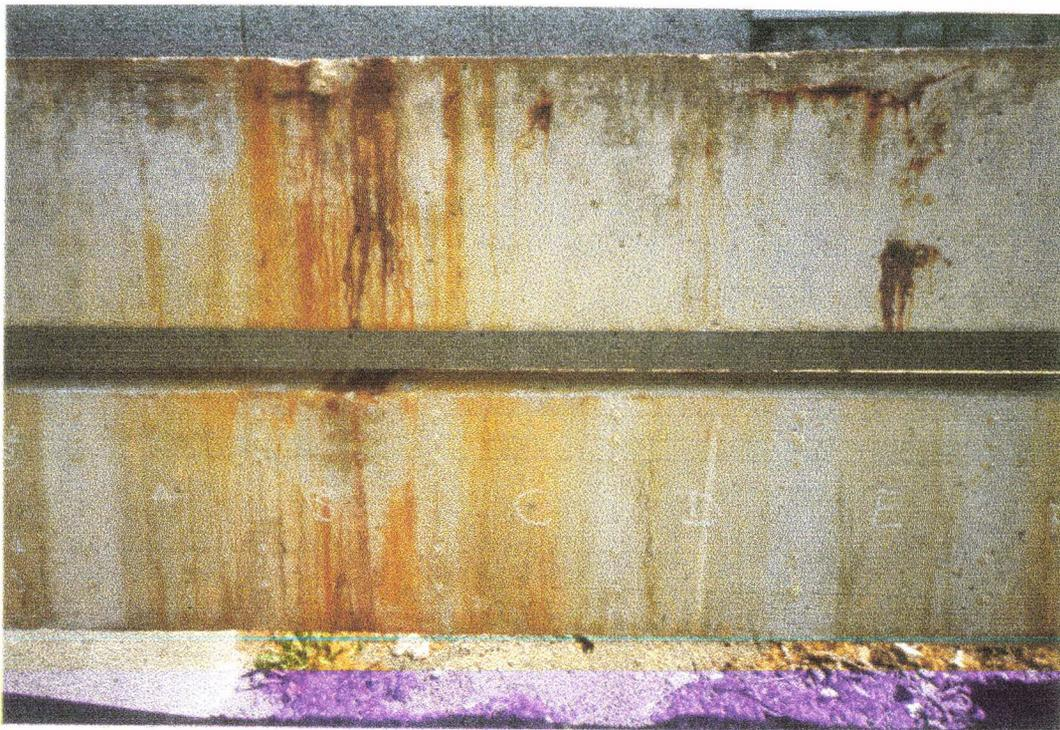
*Figure 3: Etat des poutres corrodées*
