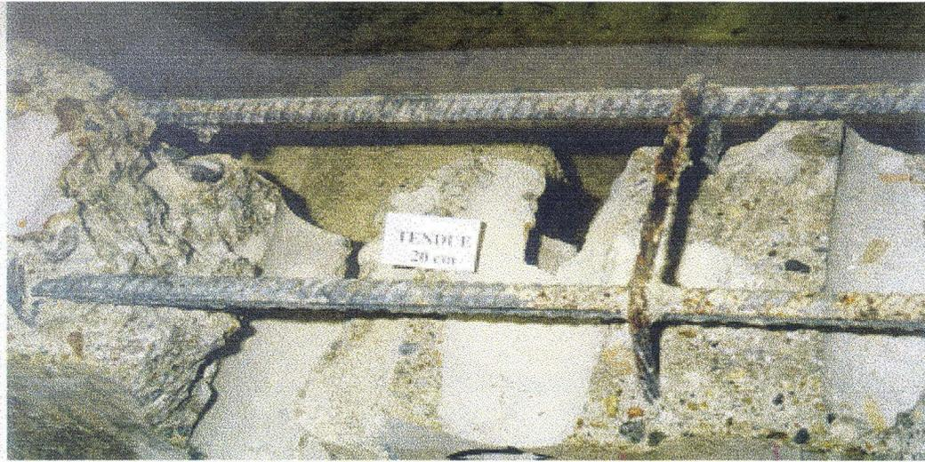
Figure 4: Etat de corrosion des armatures tendues en extrémité de poutre (GEO 1999 [61])
