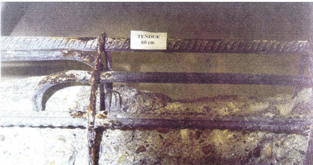
Figure 5: Etat de corrosion des armatures tendues en zone I (GEO 1999 [61])
