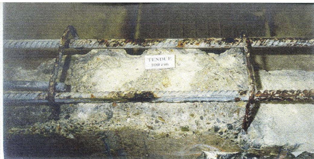
Figure 6: Etat de corrosion des armatures tendues en zone G (GEO 1999 [61])
