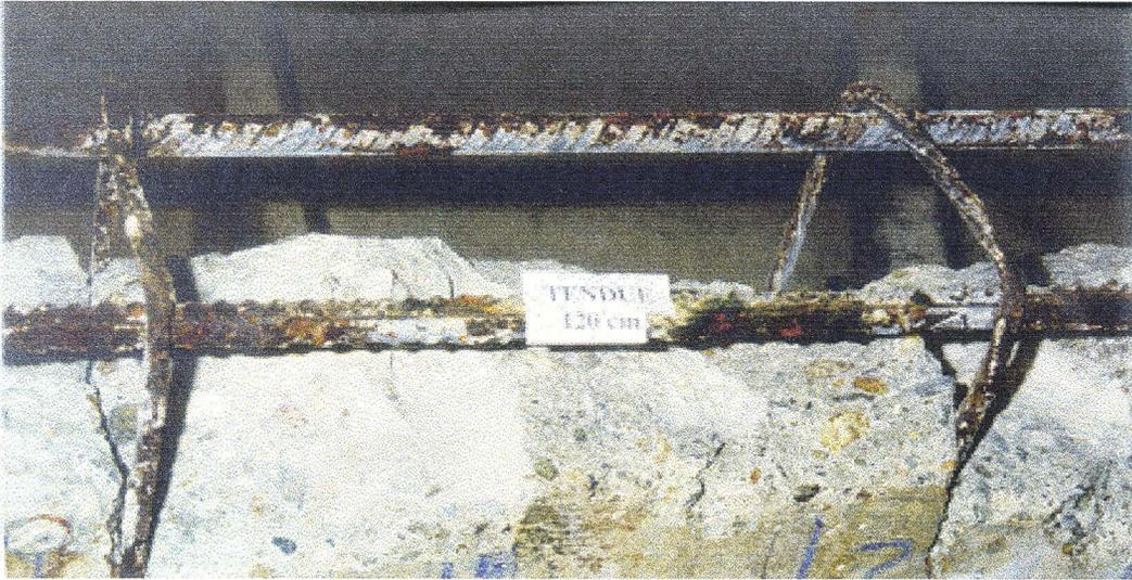
Figure 7: Etat de corrosion des armatures tendues en zone F (GEO 1999 [61])
