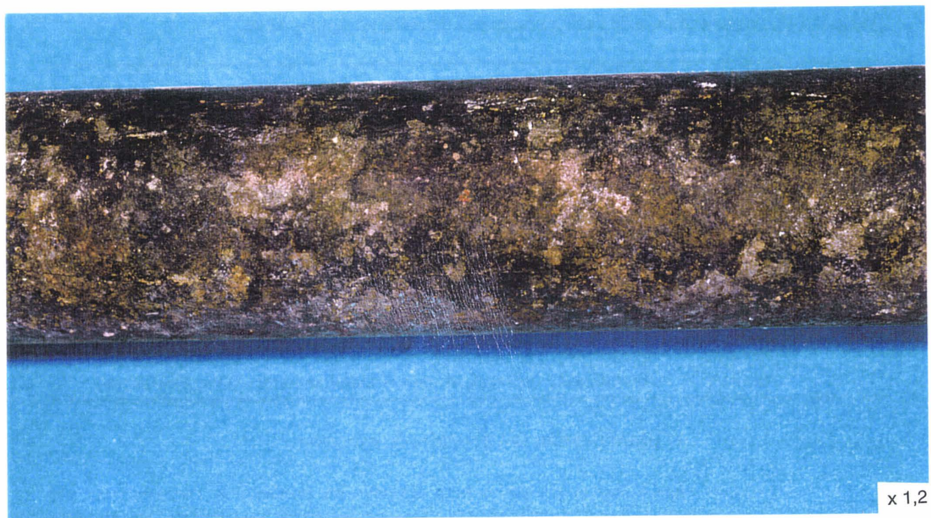
Figure 4-8 : examen macroscopique du tube en Incoloy 800 (durée de service : 40515 heures) ; Chaudière 2 de l'usine de Saint-Ouen.
