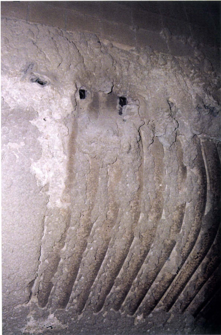
Figure 4-2 : descriptif de la zone 1 : tubes en essai au niveau du nez de voûte sur alimenteurs, au bas du mur avant de la chambre de combustion de la chaudière 1 de Saint-Ouen.
