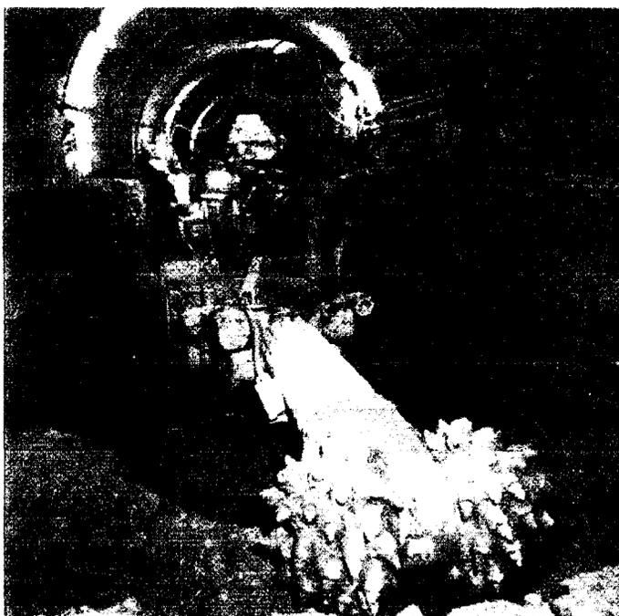
Figure 1-1 : Machine à attaque ponctuelle.
