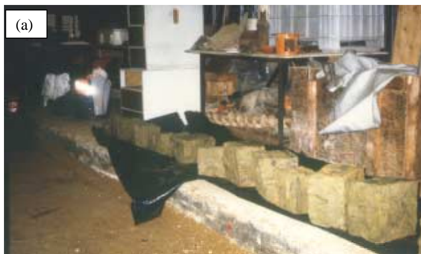
Figure II.3 : Préparation du sol, (a) Compactage à l'aide de la dame pneumatique, (b) découpage en blocs (c) Les blocs obtenus.
