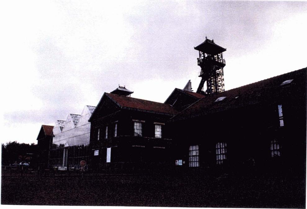
5- Verrière construite pour abriter les machines préservées et reliant les deux bâtiments des machines d'extraction. Chevalements des puits 1 et 2 en acier, de type mixte composés de poutrelles à treillis et de poutrelles à âme pleine. (Cl. H. Melin)
