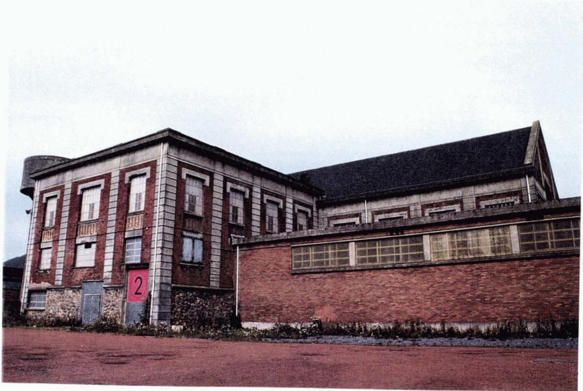
18- Salle des condensateurs à gauche, bâtiment cubique. Salle des générateurs (à droite) bâtiment du premier plan, en longueur, accolée à la salle des machines du puits 11. château d'eau en arrière plan à gauche. (Cl. H. Melin)
