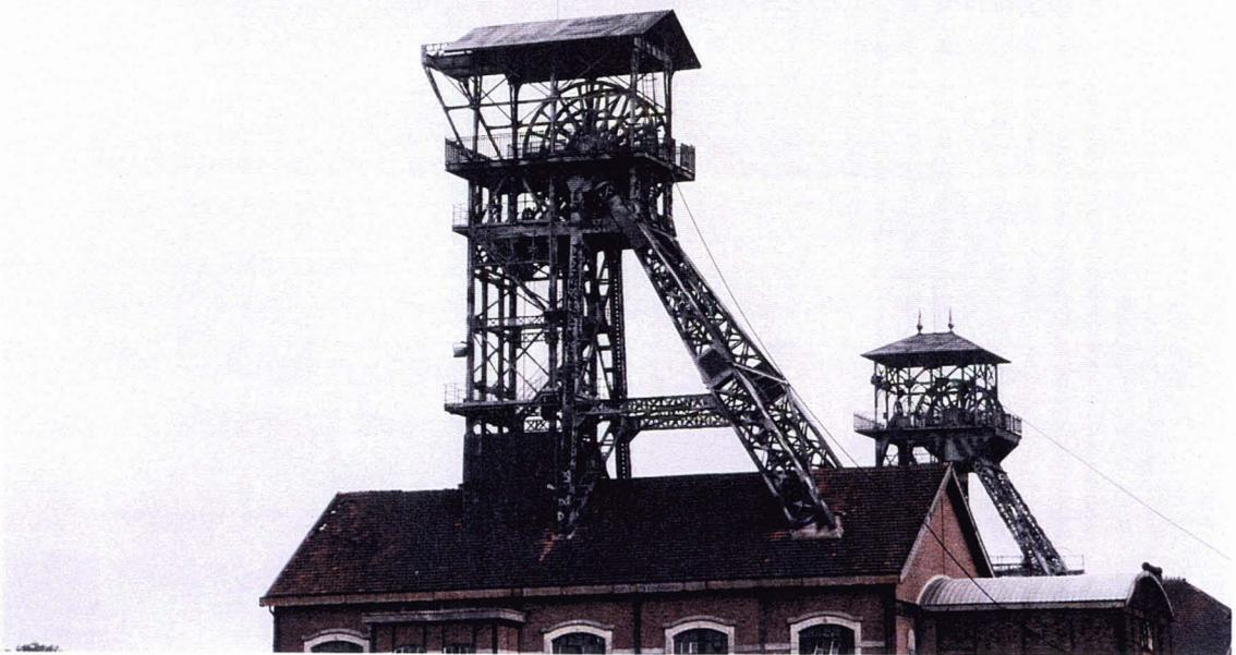
43- Vue du détail du chevalement métallique à treillis du puits 9, fosse 9-9 bis d'Oignies. (Cl. H. Melin)
