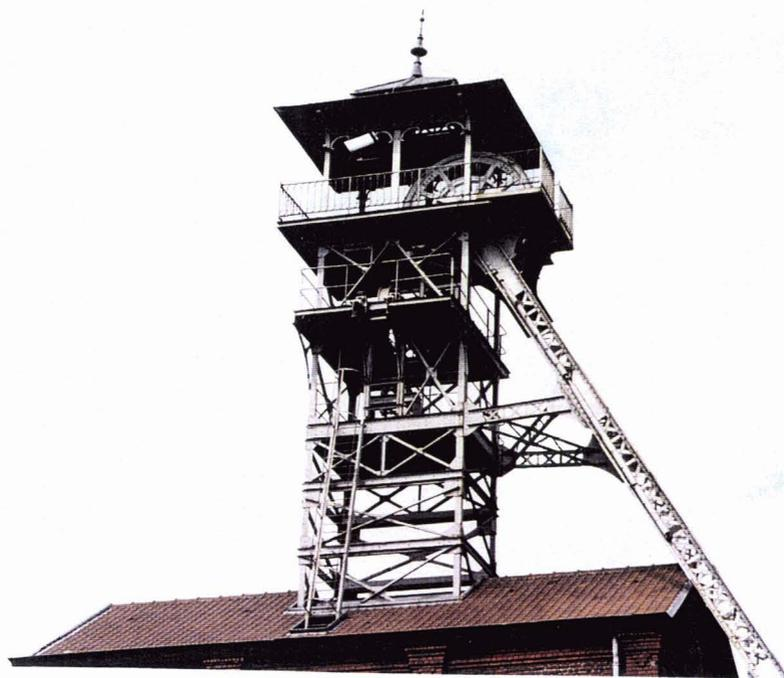
49- Haut du chevalement du puits 2 de la fosse de Wallers Arenberg, métallique à treillis.
