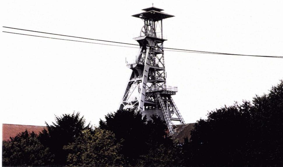
47- Chevalement du puits n°1 de Wallers. Chevalement mixte , poutrelles à treillis et à âme pleine. (Cl. H. Melin)
