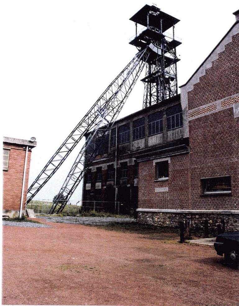
21- Chevalement du puits 11, métallique à treillis avec son bâtiment. (Cl. H. Melin)
