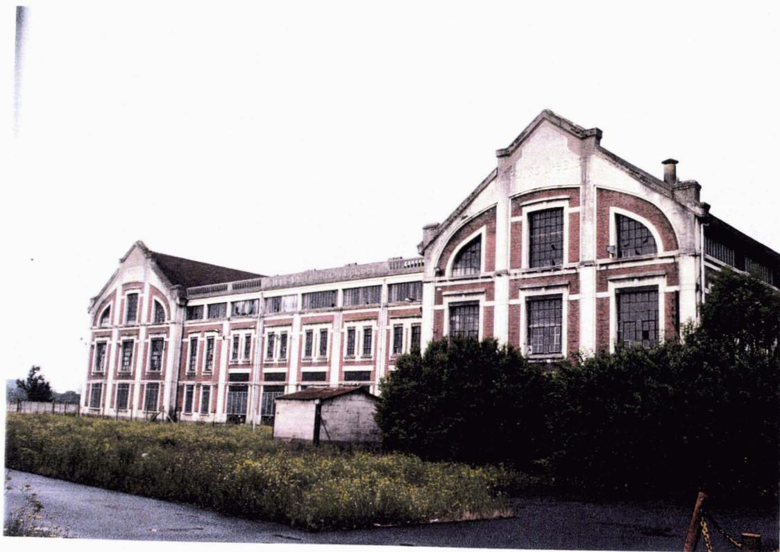
8- Façade du bâtiment principal abritant les compresseurs, les ventilateurs, le poste électrique et la machine d'extraction. (Cl. H. Melin)
