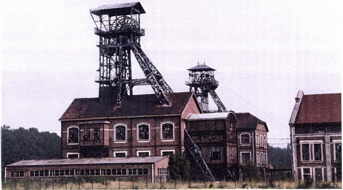
42- Chevalements de la fosse 9-9bis d'Oignies, de type métalliques à treillis et les bâtiments de production (puits 9 au premier plan et 9bis en arrière plan). (Cl. H. Melin)
