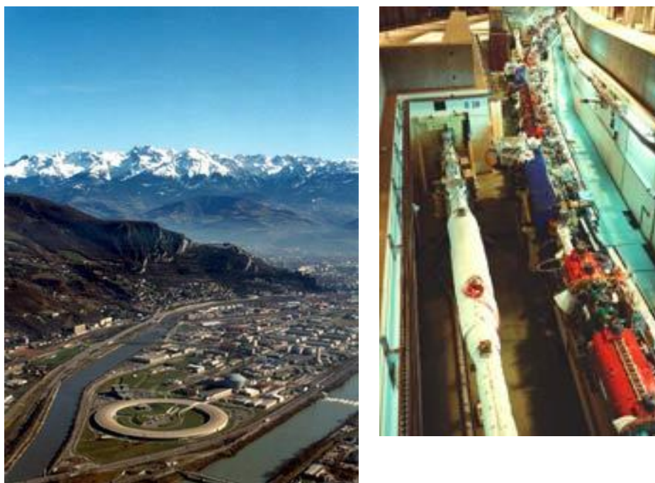
Figure 20 : Photo extérieure et intérieure d'un synchrotron (ESRF)
