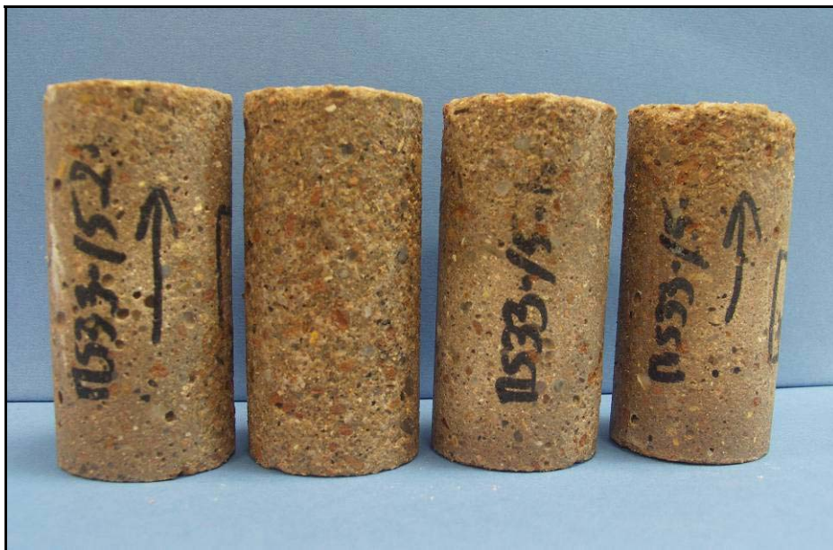
Photo 4-10: dégradation non homogène entre les échantillons (mortier MS33 0.315/4 en marnage)
