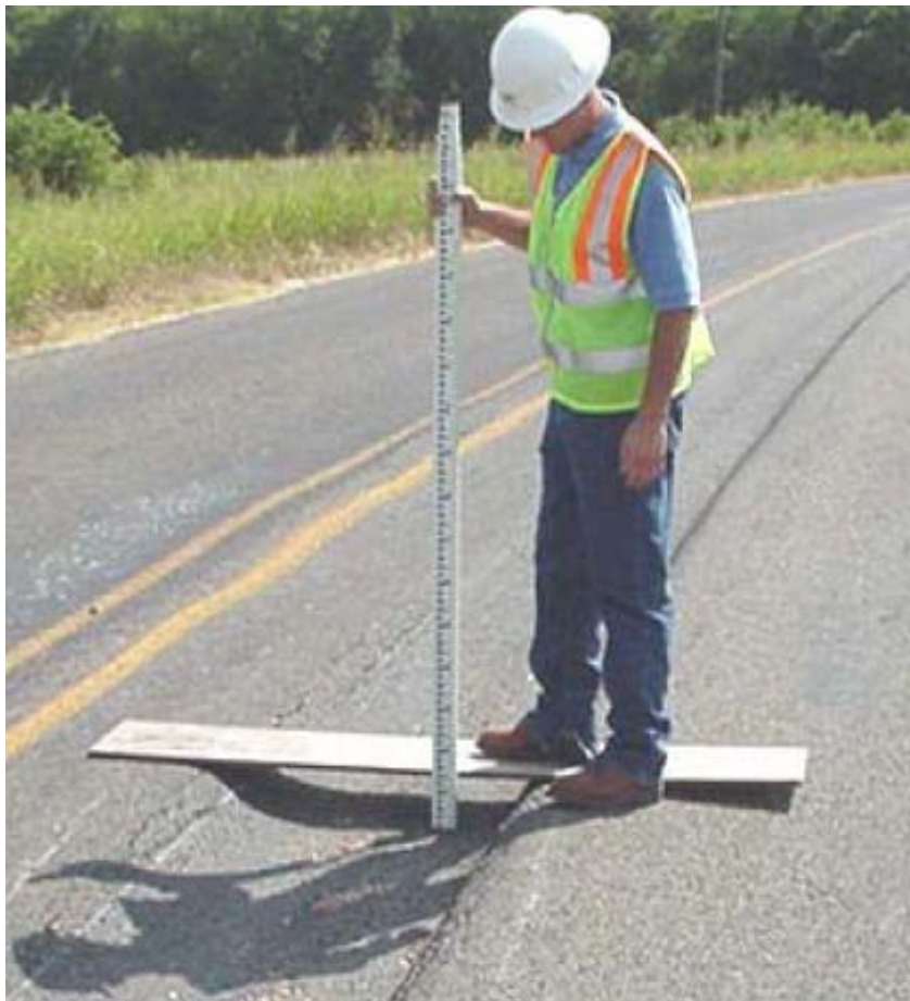
Figure 1.2 : Exemple d'une chaussée atteinte d'orniérage (Chen, 2004)
